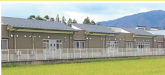
▲施設の長寿命化を図るため特別養護老人ホームふじの里なごみの家建物大規模修繕工事として外壁改修と屋根改修を行いました。
