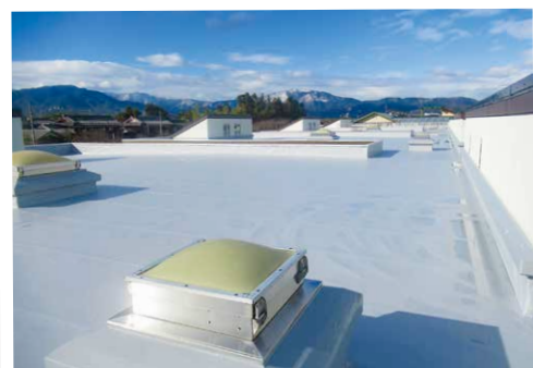
なごみの家屋上防水改修事業
